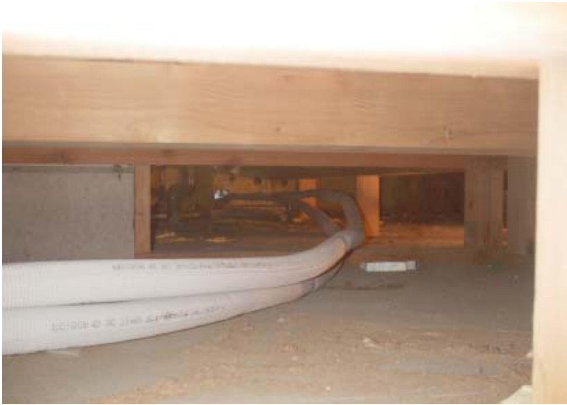
配管工事（各部屋の床暖房パネルから熱源機までの配管をします）
