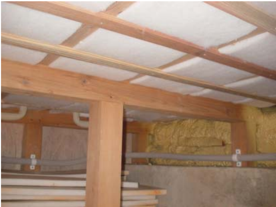
断熱受け材施工（断熱材の下に受け材を渡し、根太にビス止めします）
