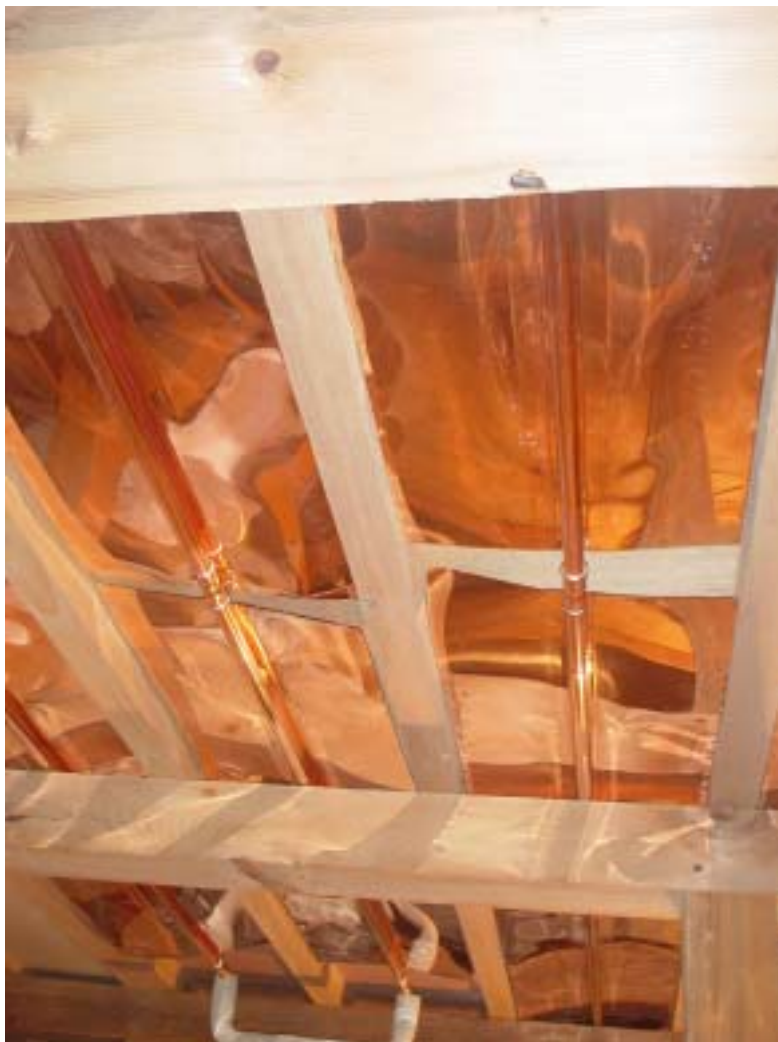
床暖房パネル工事 (既存の根太間に床暖房パネルを床下より設置します)
