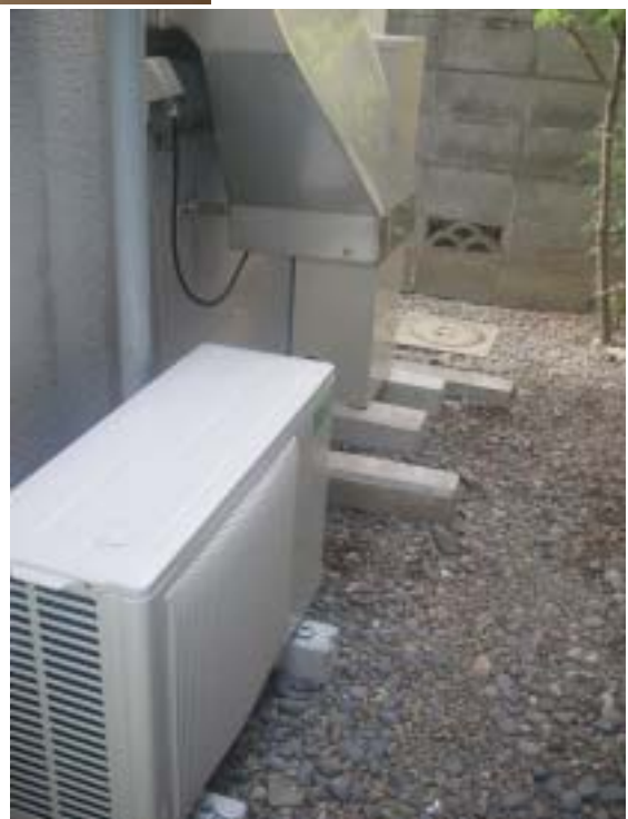
床暖房熱源機: ヒートポンプユニット エコヌクール・ピコ (三菱電機)
