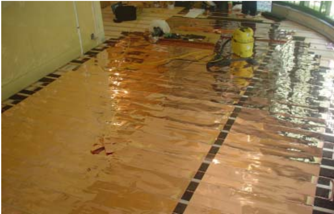
床暖房パネル工事
