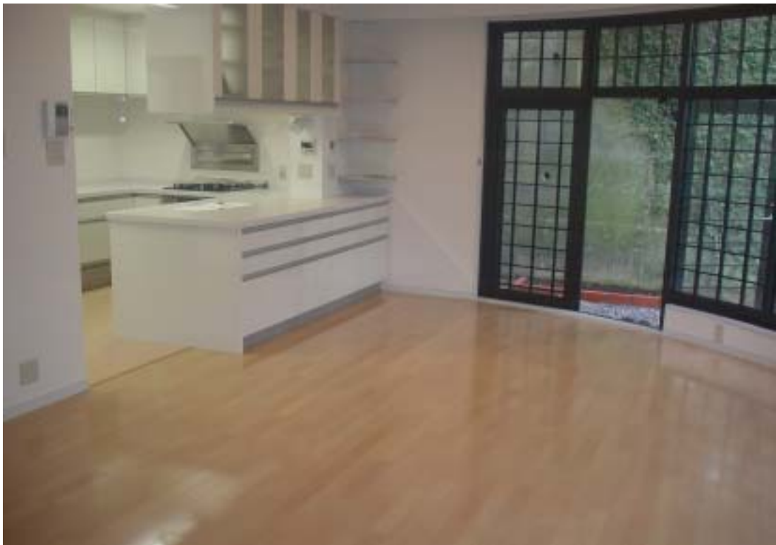
内部完成(仕上げ材:無垢フローリング)
