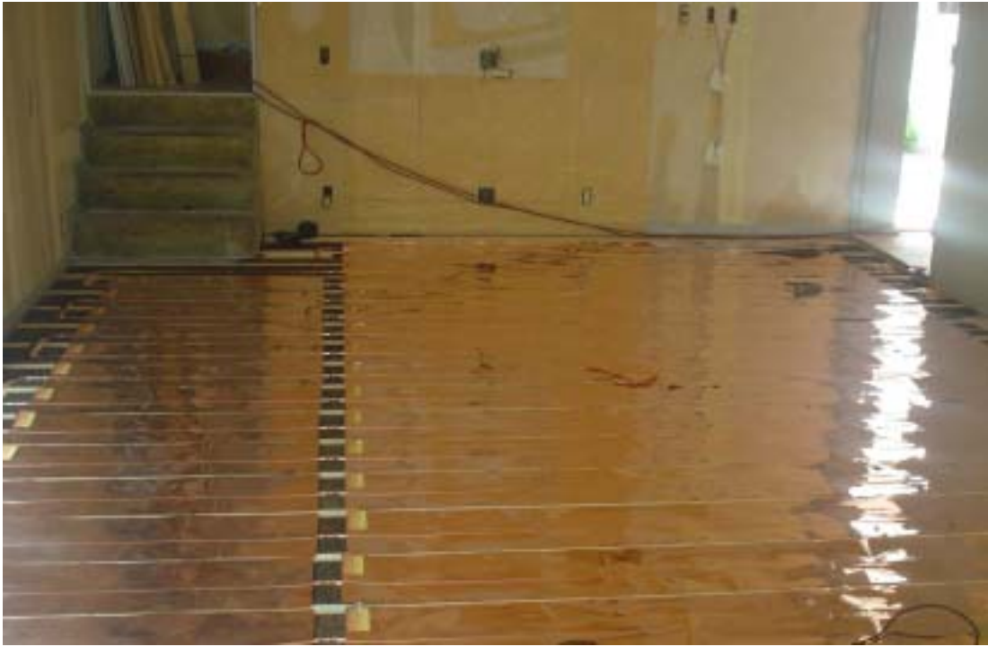
床暖房パネル工事
