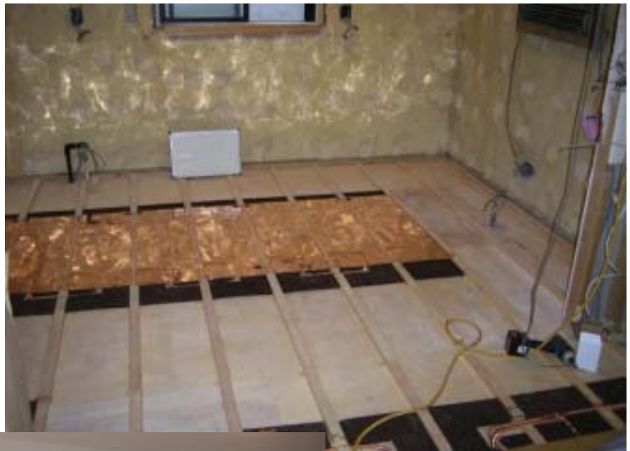
キッチン床暖房パネル工事
