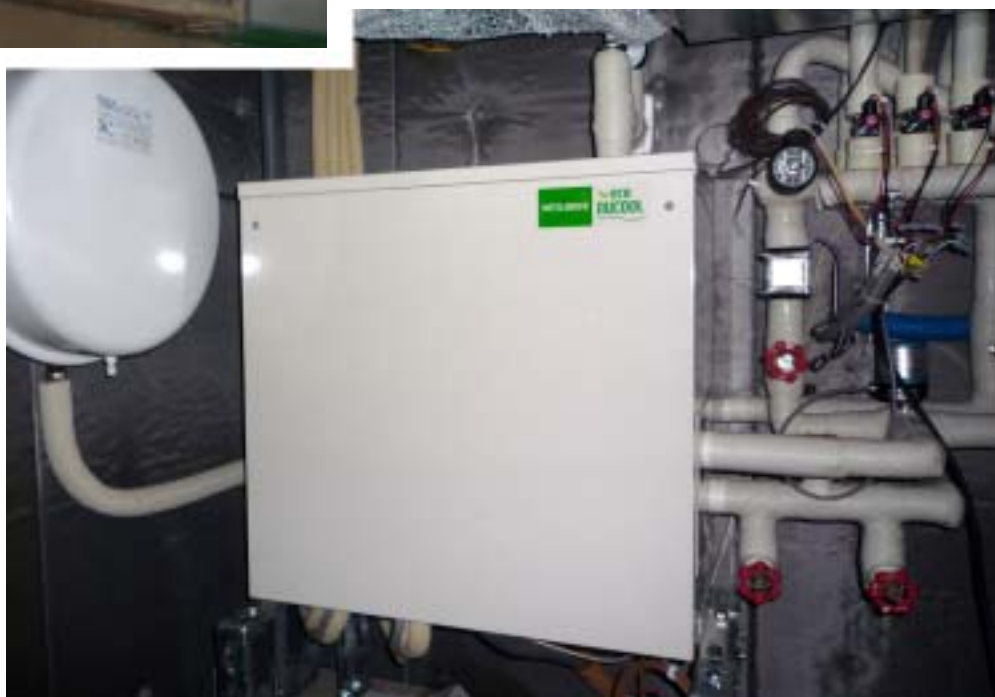
床暖房熱源機:ヒートポンプユニット エコクール・レオ(三菱電機)
