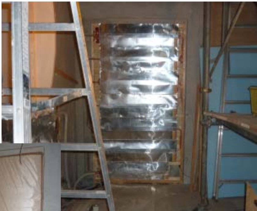
壁輻射パネル施工 (うららアルミパネル仕様)
