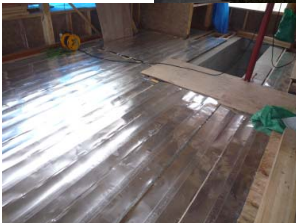
リビング 床暖房パネル工事
