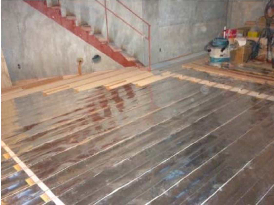
音楽室 パネル工事
