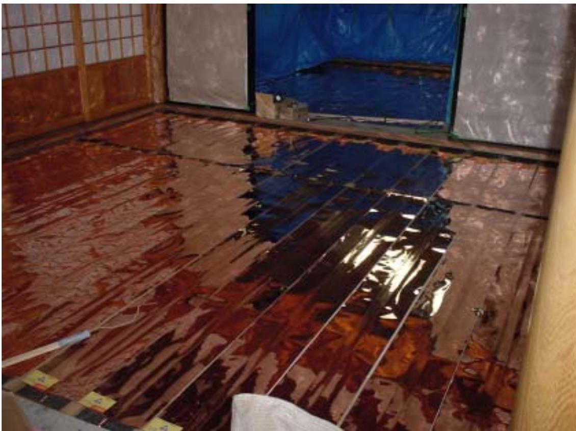
床暖房パネル工事(断熱材の上に床暖房パネルを施工)
