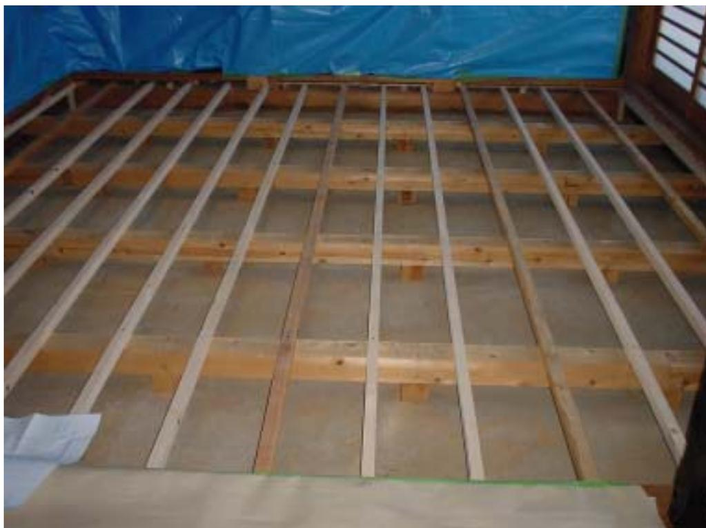
畳・荒板撤去(既存の畳と荒板を一旦取り外し、根太の状態にする)
