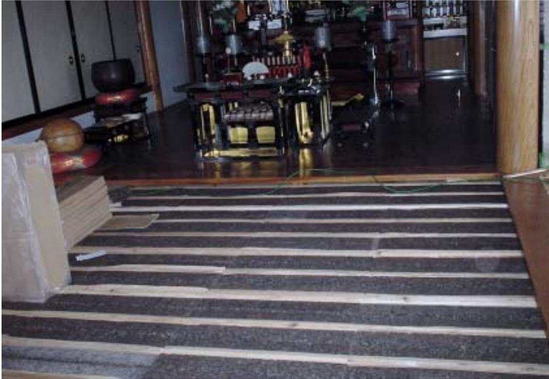
断熱材施工(既存の根太間に断熱材を設置)
